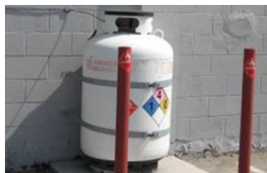
Tanque de líquido inflamable atado a la pared
