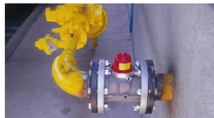
Válvula de cierre sísmico para la tubería de gas natural
