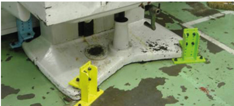
Am Boden verankerte Fertigungsmaschine
